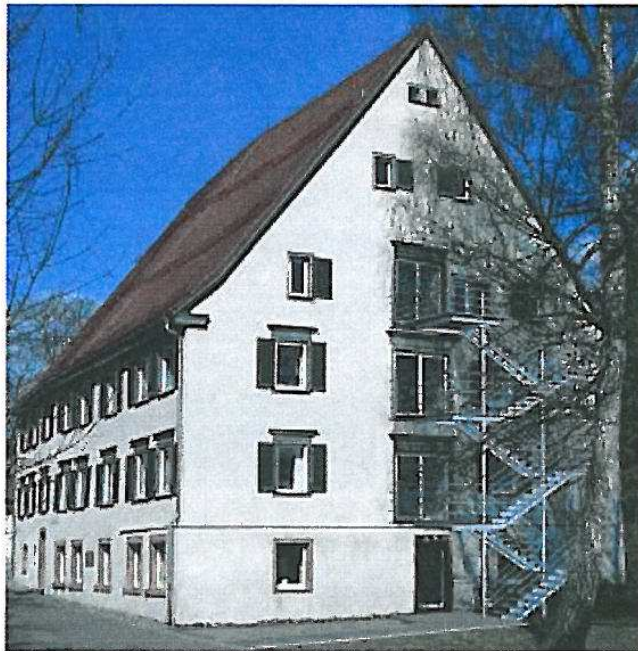
Ansicht mit Fluchttreppe
